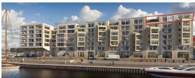
gevelaanzicht bouwdeel ZECC
